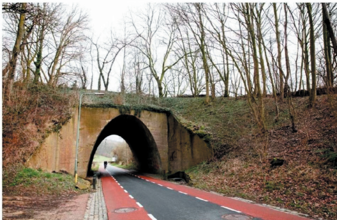
Het viaduct van de vroegere trambaan bij Reijmerstok wordt onderdeel van de vlakke fietsroute door het groene Heuvelland. FOTO DIANA SCHEILEN
